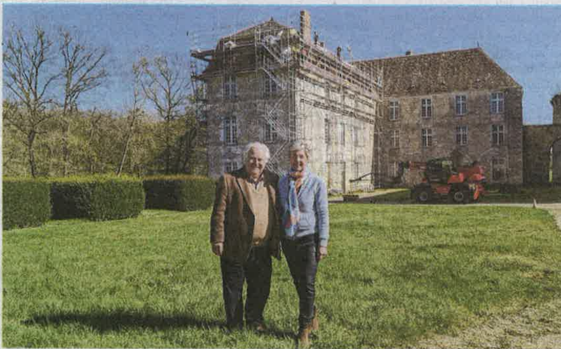
Les propriétaires devant le bâtiment conventuel dont la restauration a débuté en janvier.
